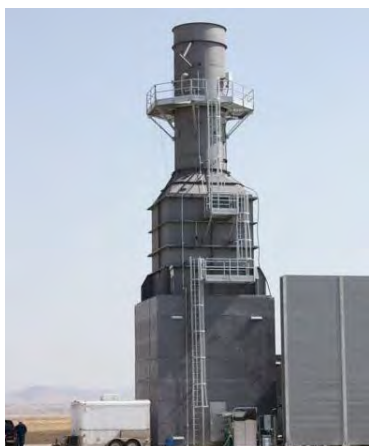
Figure 5-2: Silenciatorët vertikalë në oxhak dhe silenciatorët horizontalë brenda HRSG
