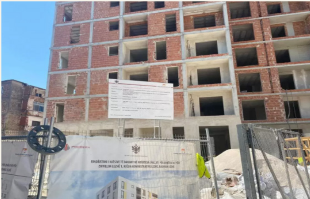
Kantier ndërtimi në rrugën "Hydajet Lezha", 14 shtator 2021
