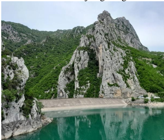
Foto nr. 3 Pamje nga Diga e Bovillës
